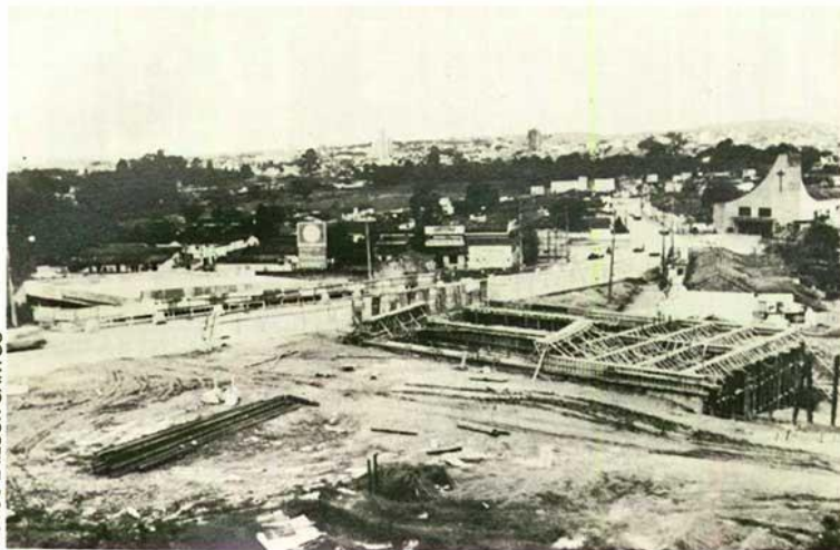
Obras da rotatória: redução de 60% no tráfego do centro da cidade
