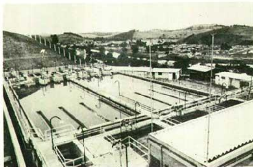
Estação de Tratamento: 490 litros por segundo
