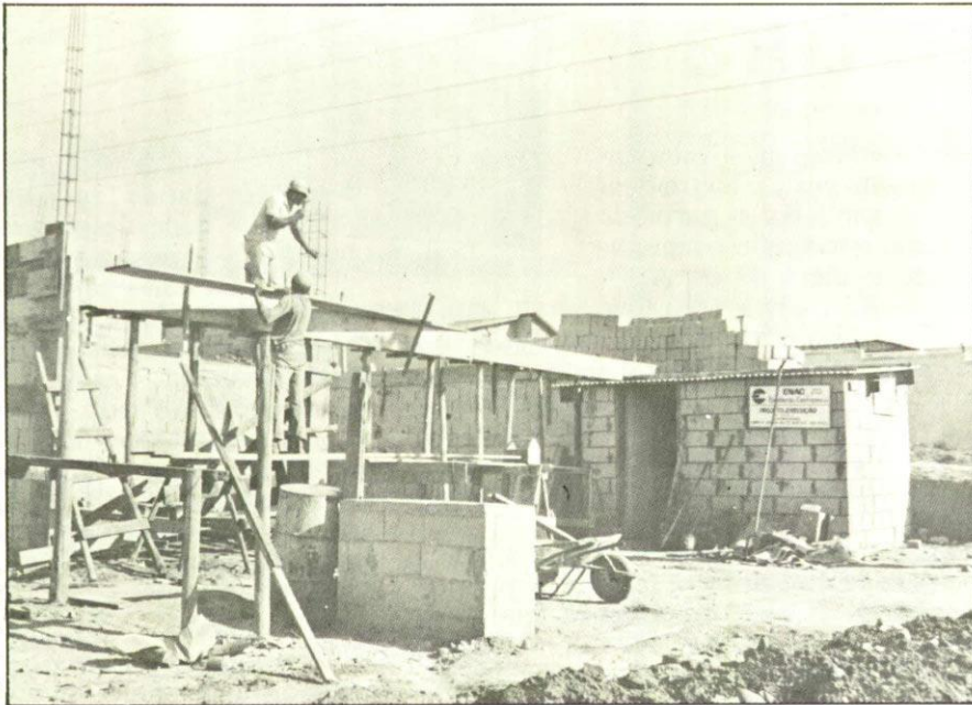
E os prédios continuam a surgir
