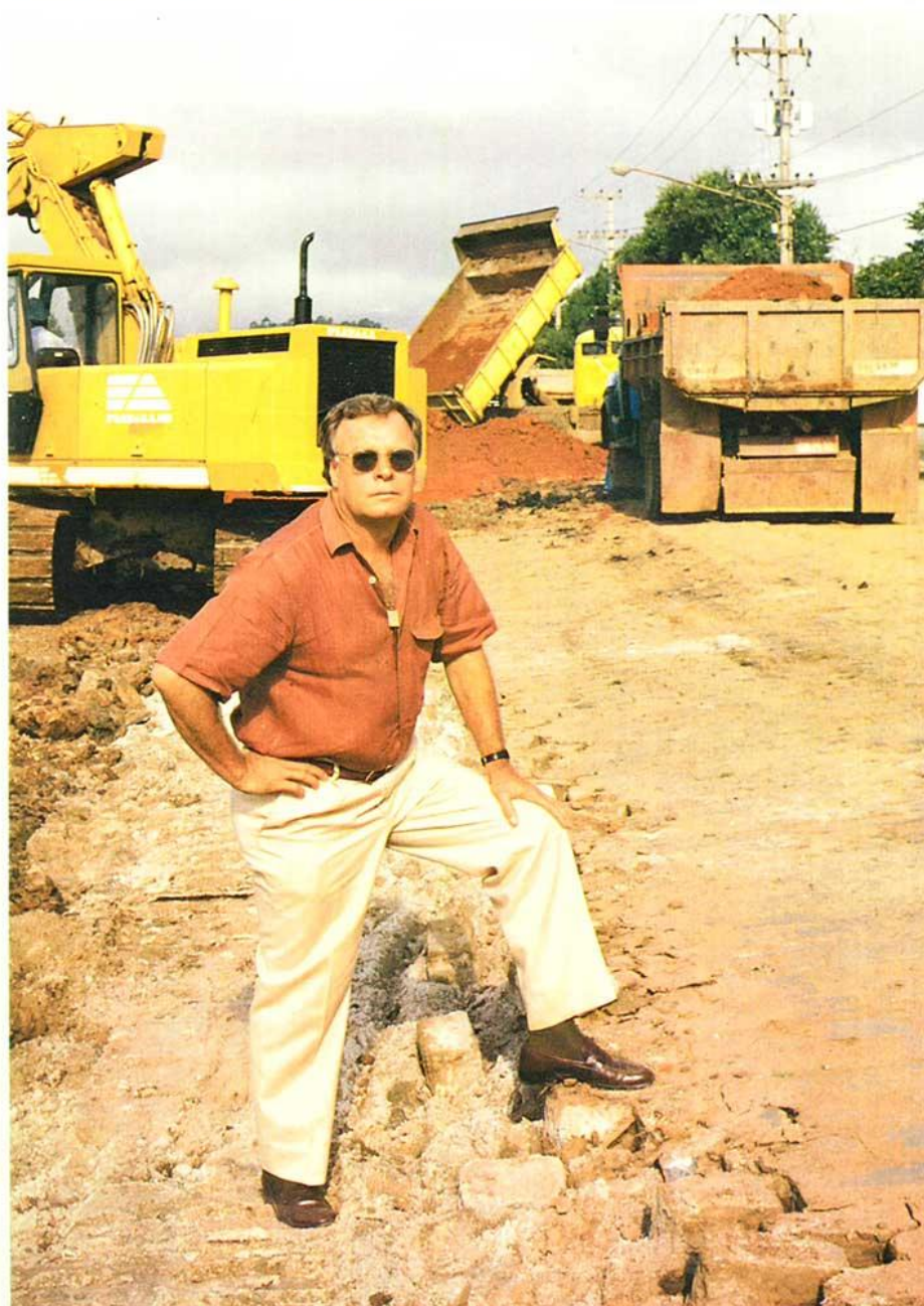
O prefeito Estevam vistoriando obras: marca de uma administração dinâmica
