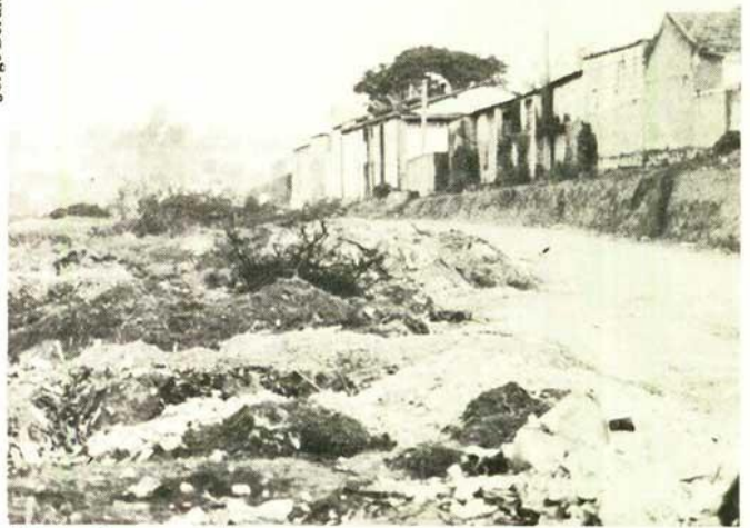
Muito lixo e entulho
