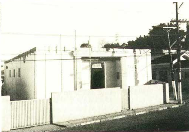
Maçonaria: multada e parada
