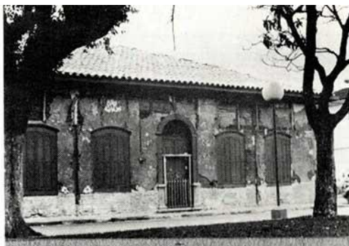
No Carmo, uma louvável restauração
