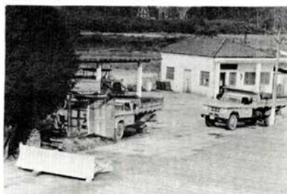
Pátio do DER: um quadro desolador
