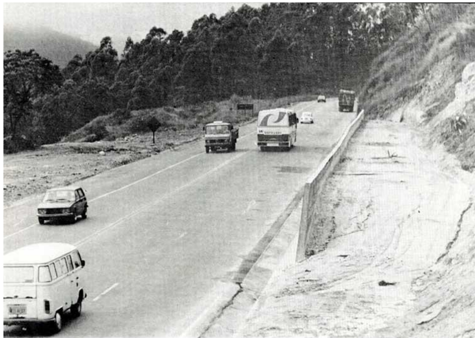
Mogi-Dutra: obras caras para conter uma erosão e deslizamentos antigos
