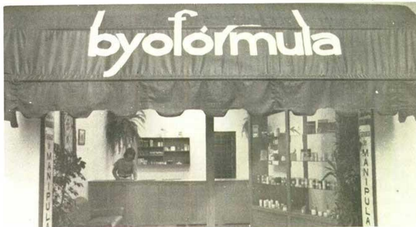
Fachada da Byofórmula da rua Cel. José Monteiro, em São José dos Campos
