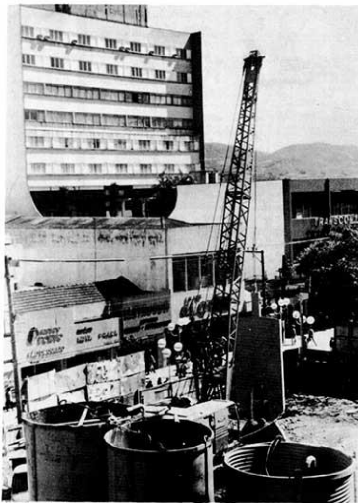
Riachuelo: fase final das obras de fundação do prédio
