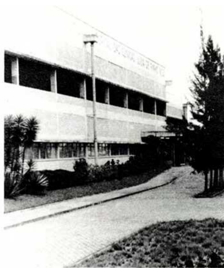
O prédio do hospital: obra inacabada
